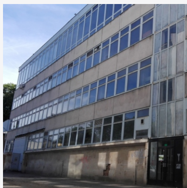
Budova D Libereckého kraje - jedna z evidovaných lokalit
